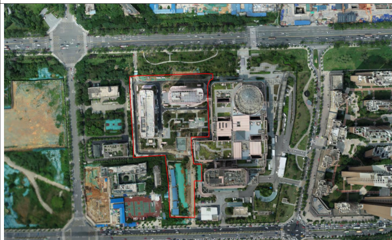
2021.08（主体施工完毕，进行收尾）
